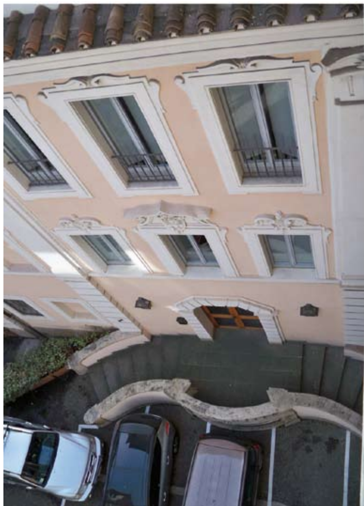
Prospetto sul cortile del Palazzetto storico
