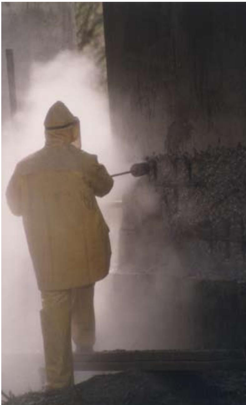
*Risanamento di strutture in cemento armato mediante idroscarifica*
