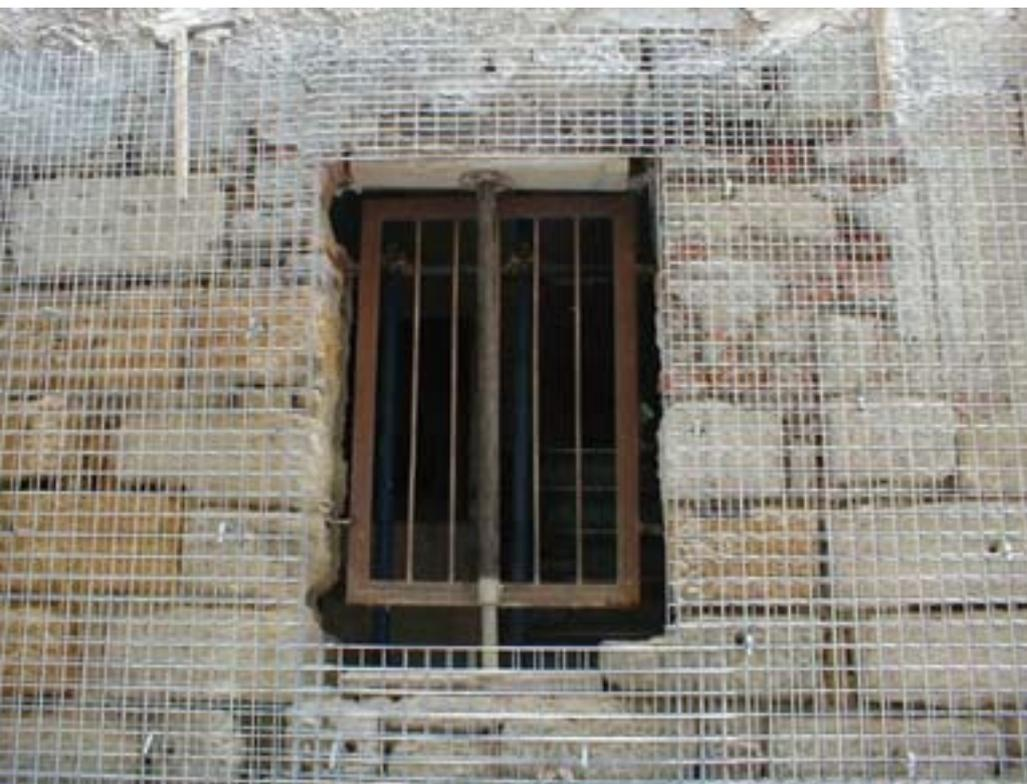
*Consolidamento con betoncino armato di un edificio storico. Fase 1: la posa dell’armatura*
